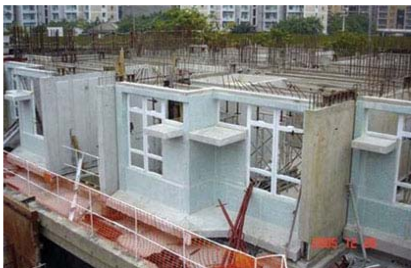
■ 在葵涌分層工廠大廈工程採用先進的預製混凝土技術
