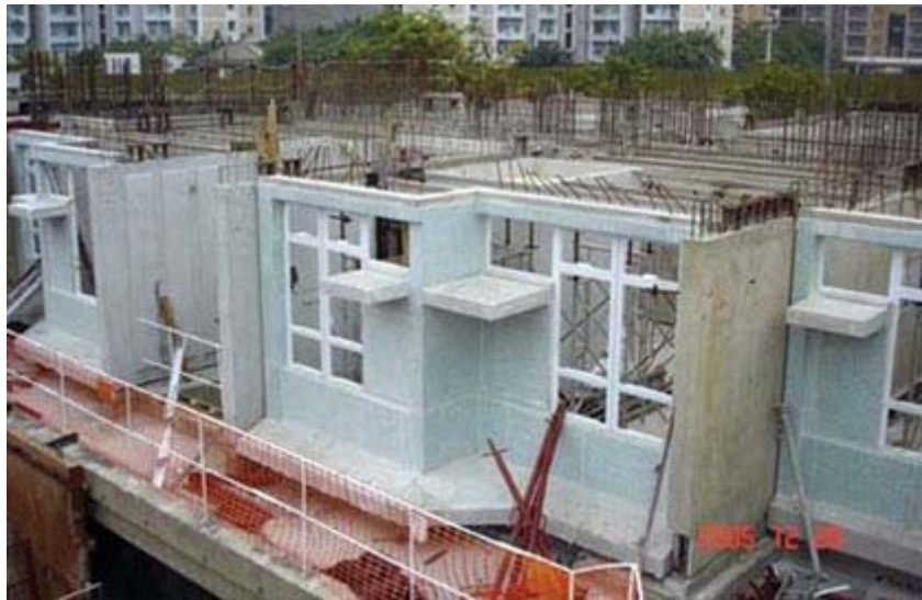
■ 在葵涌分層工廠大廈工程採用預製混凝土組件建築技術
