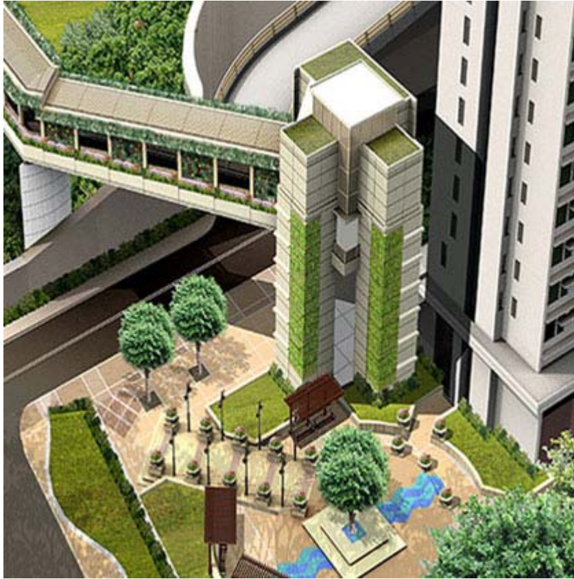
■ 東區海底隧道旁公屋發展第 4 期採用垂直式綠化預製組件（工程進行中）
