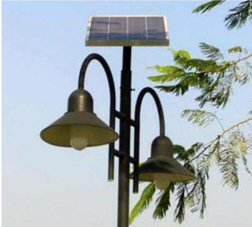
■ 為戶外照明系統安裝太陽能電池板
