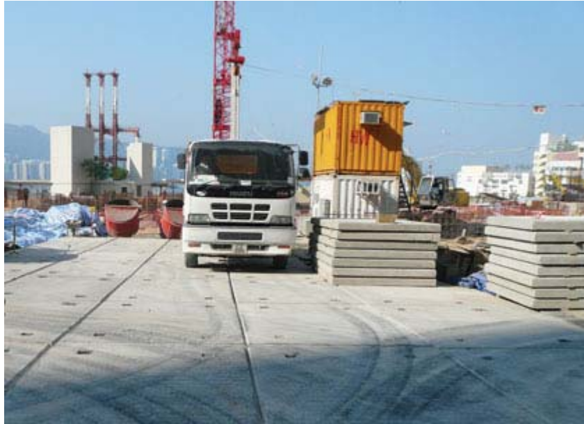
■ 在房委會其中一個建築地盤採用的硬地施工法
