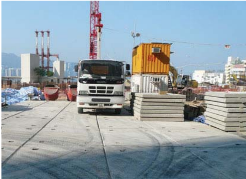
在房屋委員會一個建築地盤採用硬地施工法
