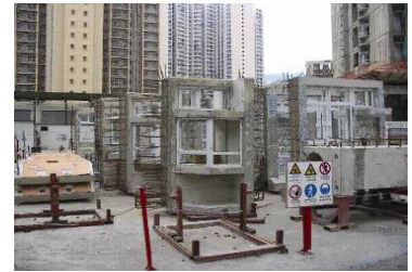
預製組件儲存空地
