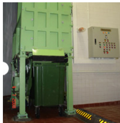
安裝於每座住宅樓宇的小型「分散式壓縮系統」
