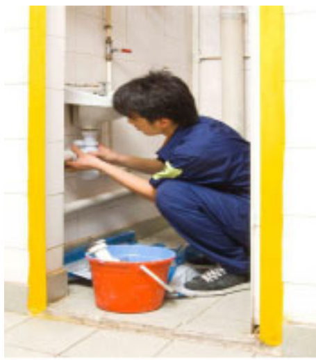
全方位維修計劃的維修服務
