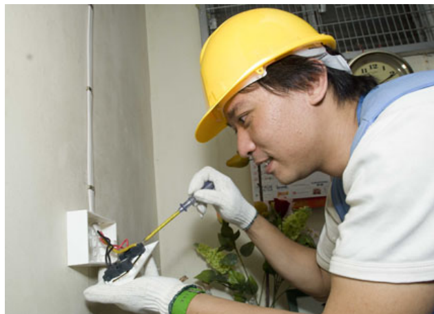
重鋪住宅單位的電線
