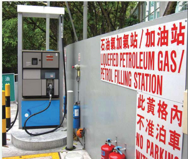
▲ 附設石油氣加氣設施的加油站
