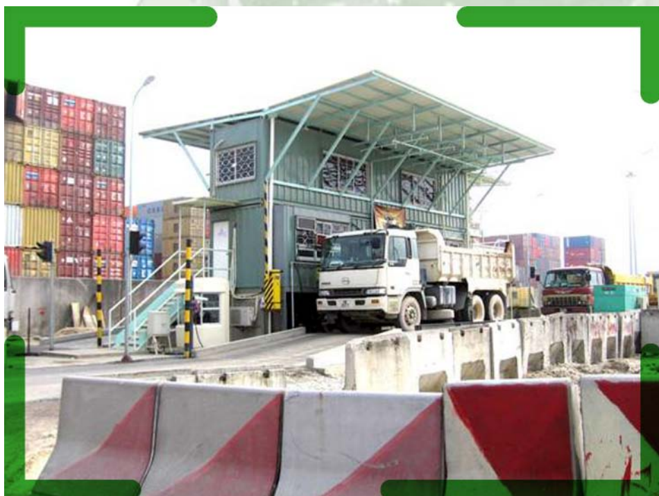
在屯門第38區的建築廢物分類設施設置秤車量重器 Weigh-bridge of construction waste sorting facilities at Tuen Mun Area 38
