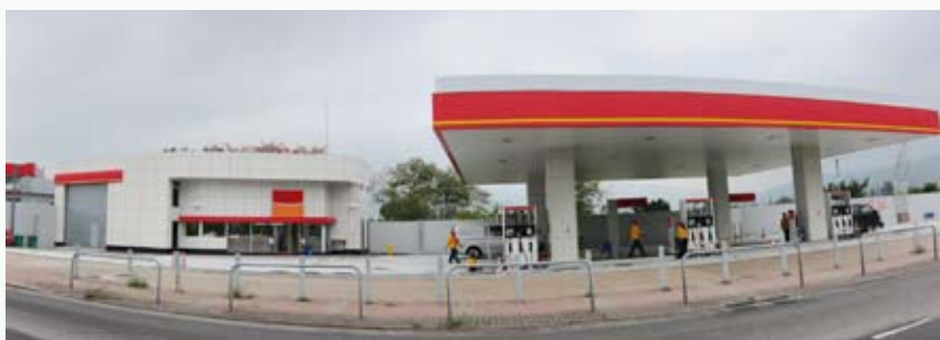
附設石油氣加氣設施的元朗錦田公路加油站
