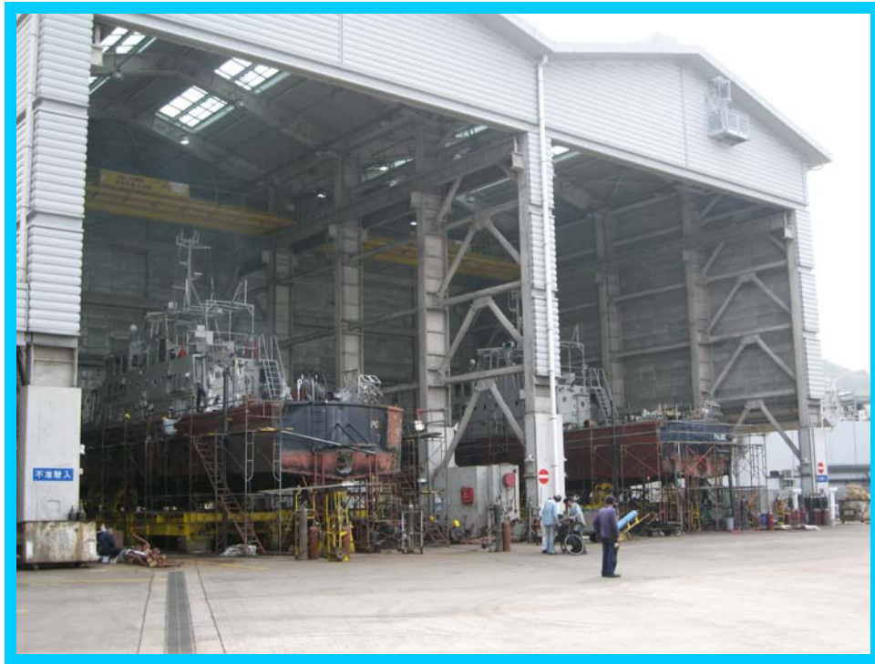
政府船隻在有蓋工作棚內修理
