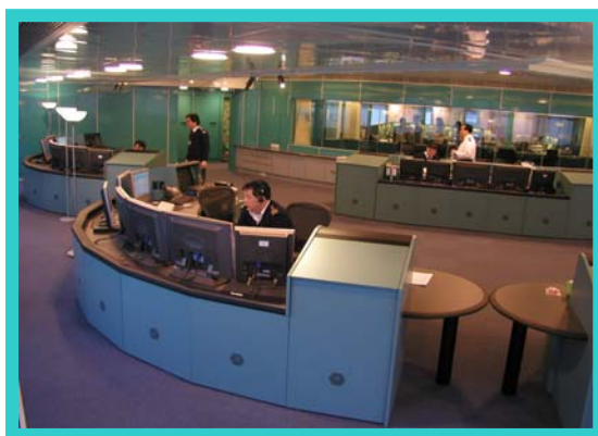
設於港澳客運碼頭內的航監中心
