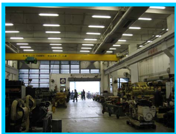
去油工場內已老化的高棚燈已由節能熒光照明系統取代
