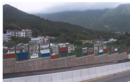
設於西貢公路的隔音屏障
