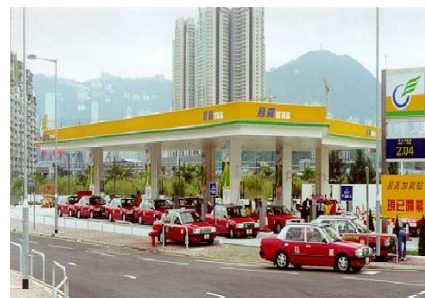
石油氣加氣站
