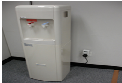
在蒸餾水機安裝7日時間掣，可在辦公時間後自動關掉水機的電源。
