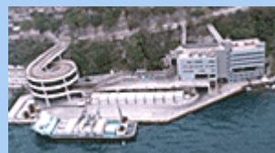
港島西區廢物轉運站
