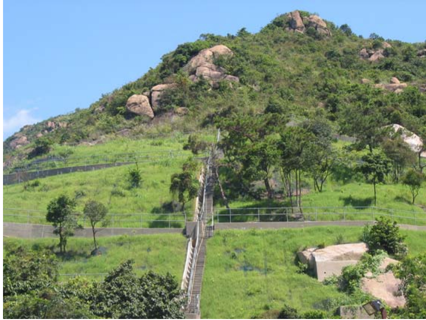
位於青衣的其中一個經防止山泥傾瀉計劃鞏固的人造斜坡上的綠化工作
